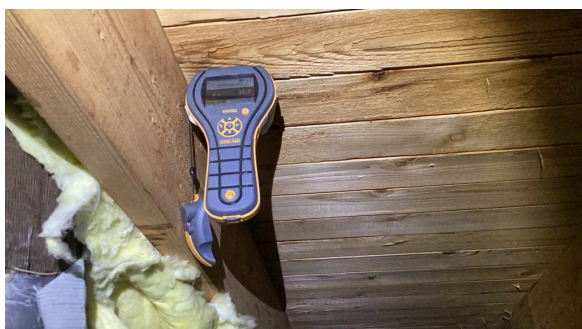
Ved enkel fuktmåling registrerte jeg tørre verdier.
