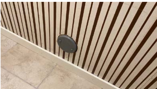
Stakeluke på bod i underetasje.
