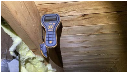
Ved enkel fuktmåling registrerte jeg tørre verdier.
