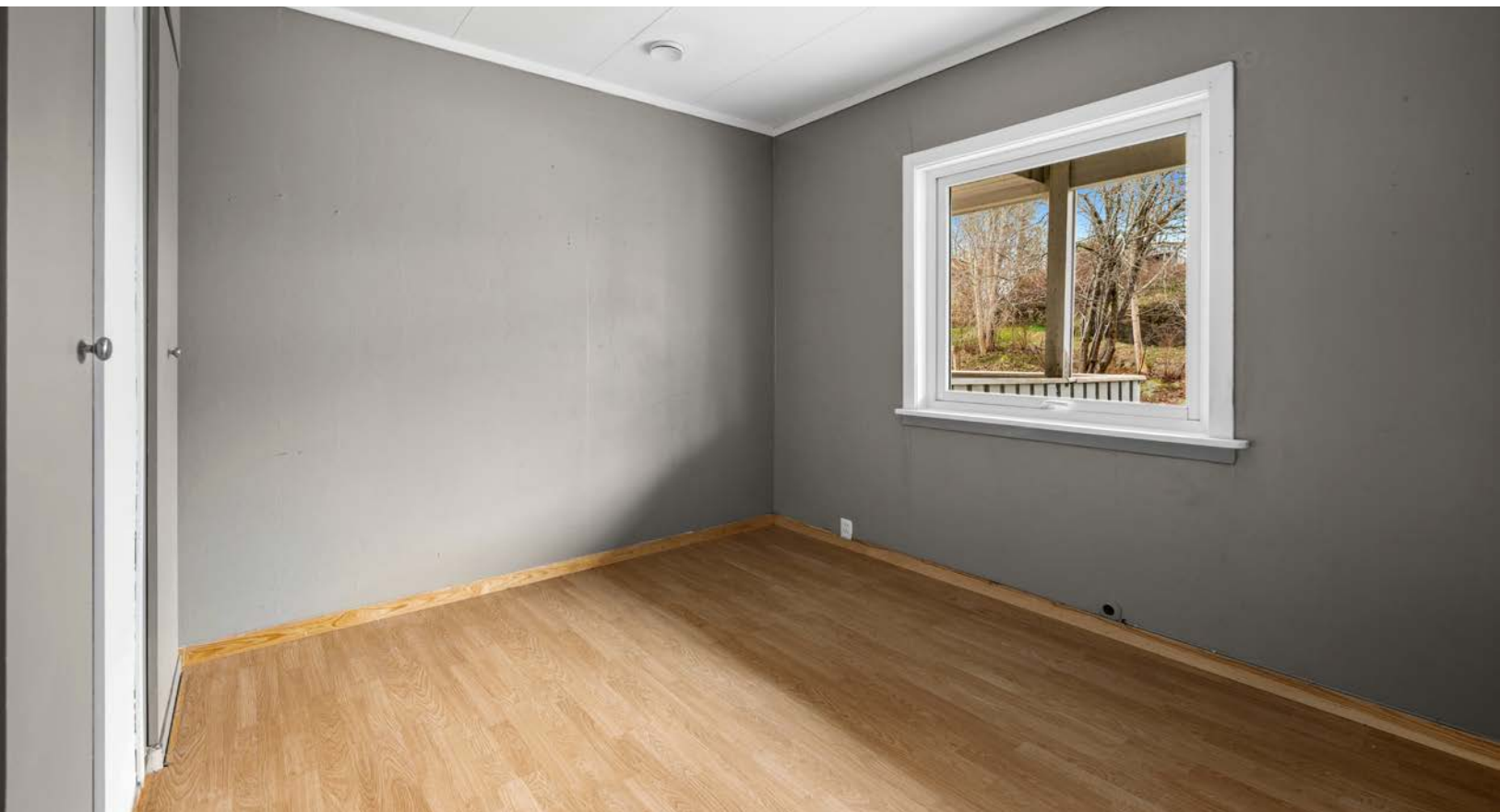
1. etasje: Soverom to med garderobeskap
