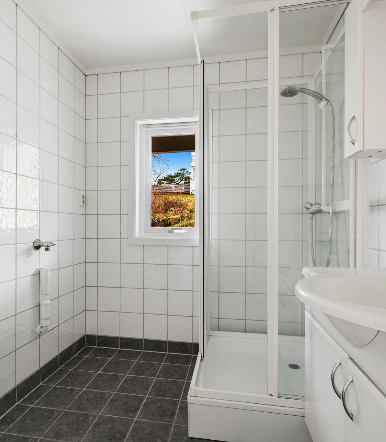
1. etasje: Badet ble renoverert i 2006, med flislagt gulv m/ varmekabler, flis på vegg og nymalt tak-ess i himling
