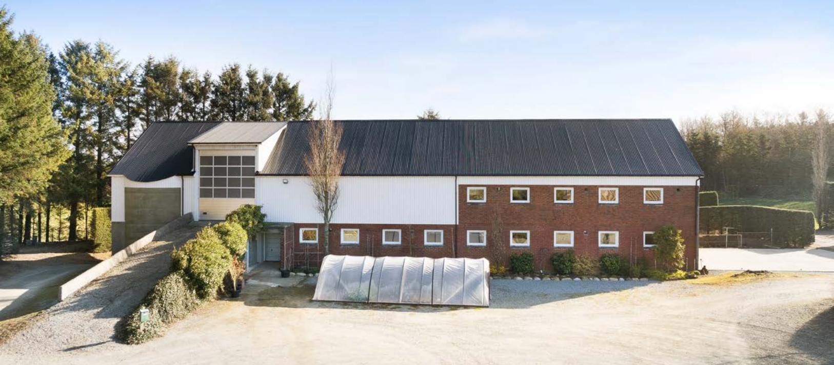
Driftsbygning fra 1966 og betydelig oppgradert i 2021 med blant annet nye takplater, veggplater og vinduer
