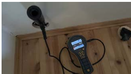
Det måles et fuktinnhold i treverk over faren for en utvikling av skader ved hulltaking i påforet vegg.
