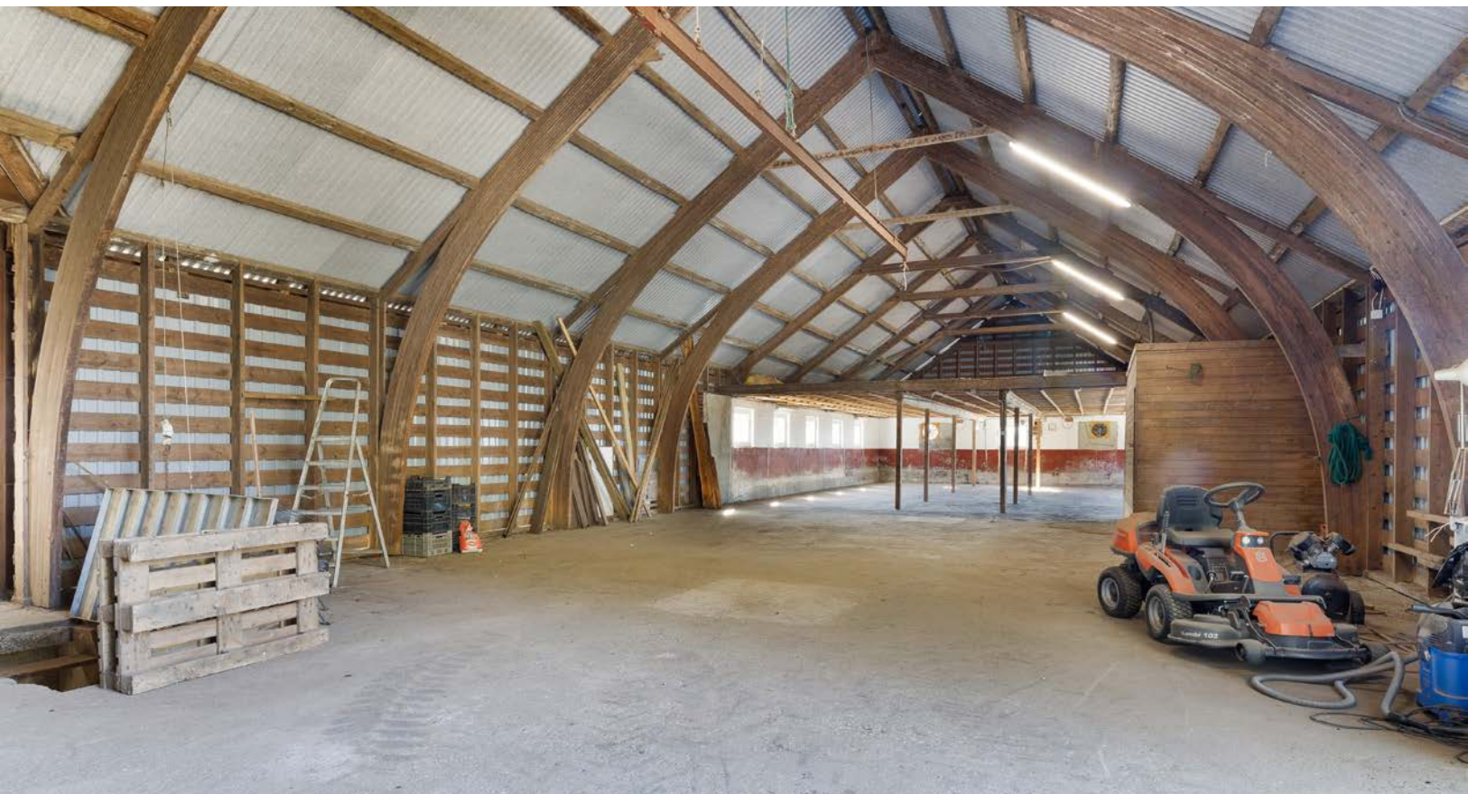
Driftsbygningen er totalt 1047 kvm - denne etasje er 307 kvm.
