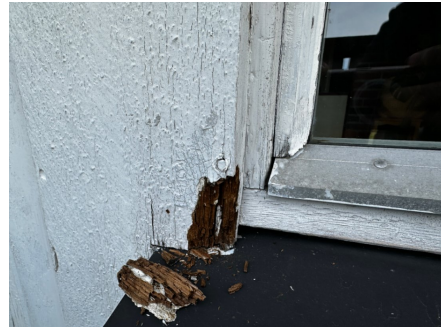
råteskade vindusbelisning
