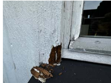
råteskade vindusbelisning
