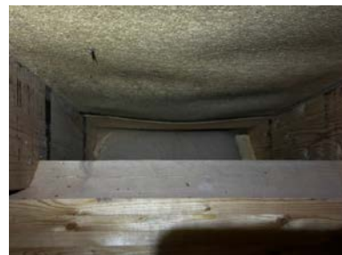
Isolasjon ligger opptil undertak
