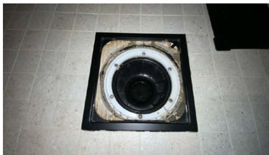
Kontroll av sluk.
