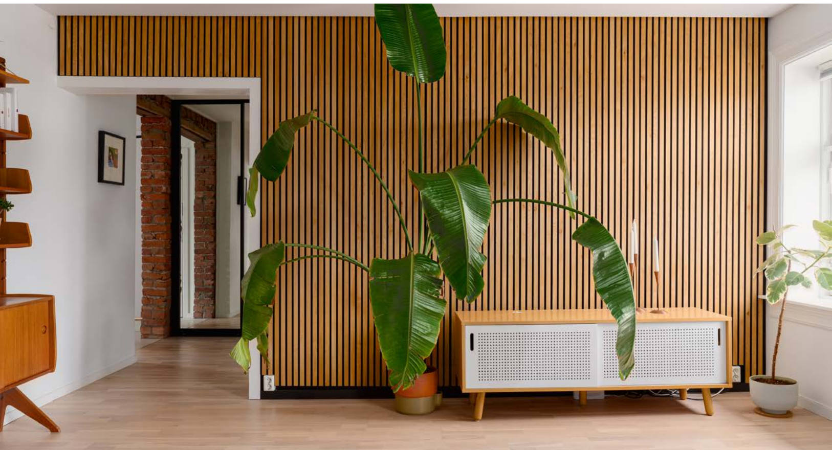
Denne vegg er belagt med akustikkpanel med spiler. Den gjennomgående bruken av eik binder rommene harmonisk sammen.
