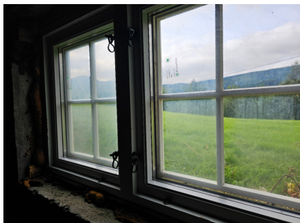
Punkttert vindu i kjeller
