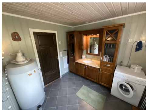
Viser installasjoner på våtrommet.
