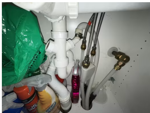
Viser vann og avløpsinstallasjoner under kum.
