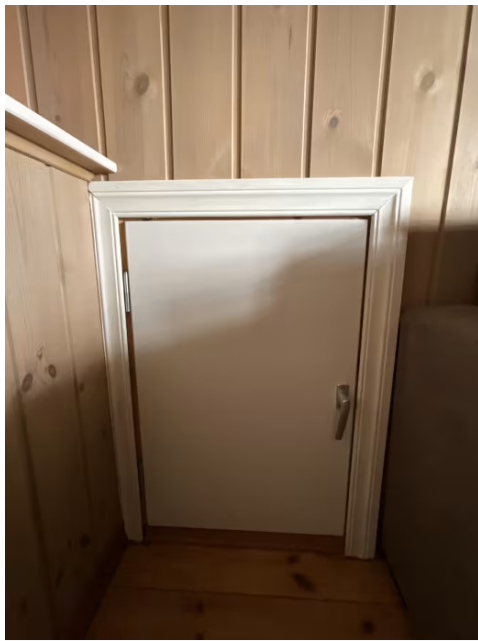
Loft med adkomst fra luke i knevegg fra stue i 2.etasje
