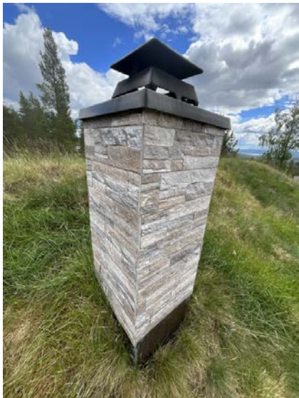
Viser pipe over tak.
