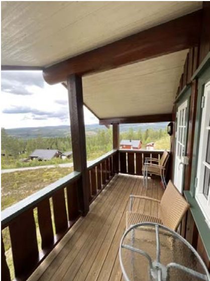
Viser overbygget balkong med adkomst fra stue i 2.etasje.
