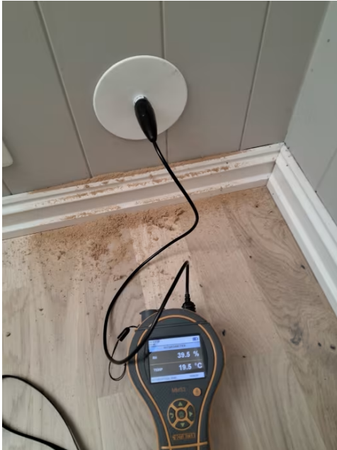
Bilde fra fuktmåling i utlektet veggkonstruksjon.
