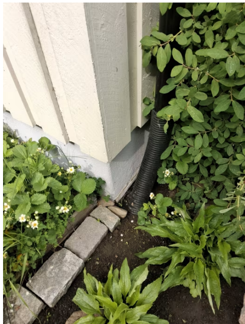
Taknedløp er ført ned i drensrør.
