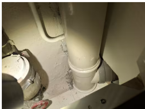
Deler av avløpsrørene er fra byggeår.
