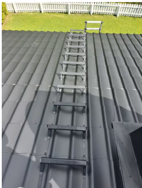
Detner etablert takstige til pipe.
