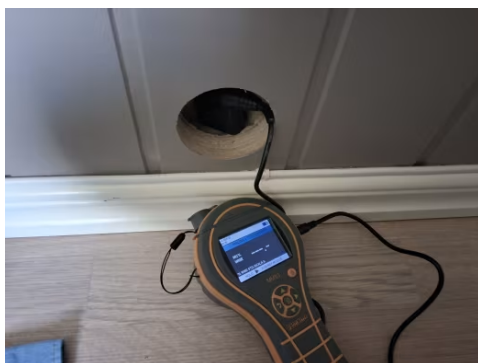
Bilde fra fuktmåling i veggkonstruksjon tilstøtende våtsone.
