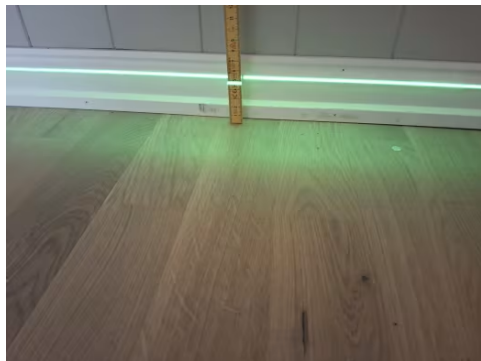
Etasjeskiller er kontrollert med nivelleringslaser.
