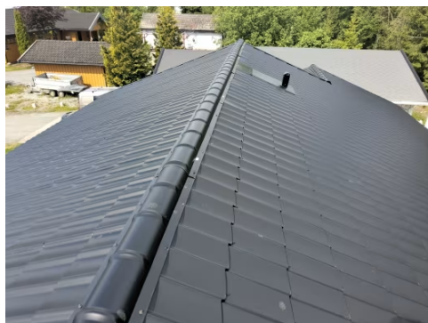
Taket er tekket med lakkerte stålplater.
