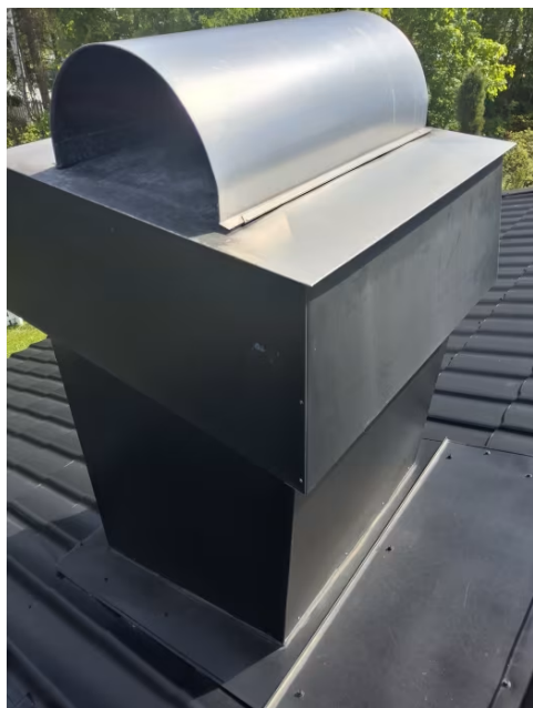
Pipen er beslått med heldekkende pipebeslag.
