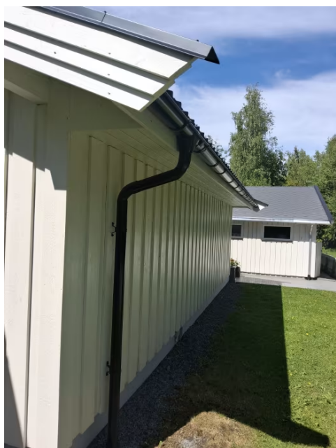
Boligen har takrenner og nedløpsrør av metall.
