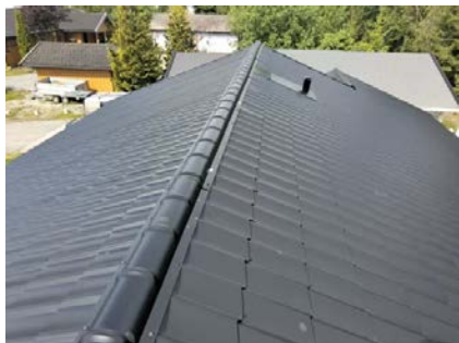
Taket er tekket med lakkerte stålplater.
