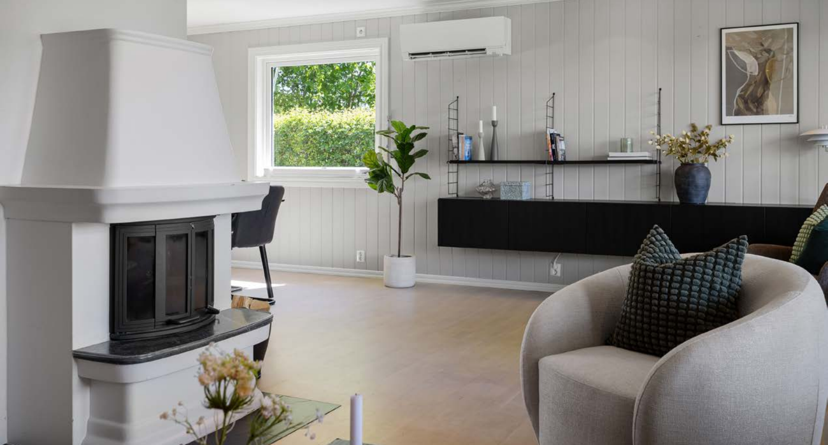
Også i stuen er det montert varmepumpe som gir jevn og god varme.
