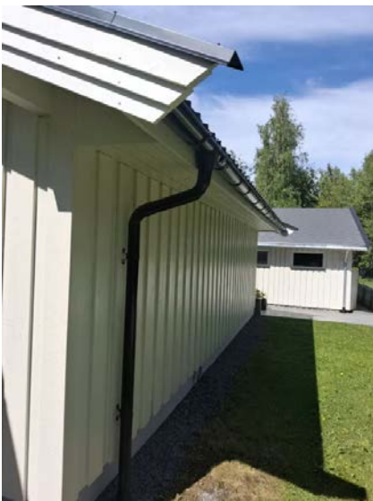
Boligen har takrenner og nedløpsrør av metall.
