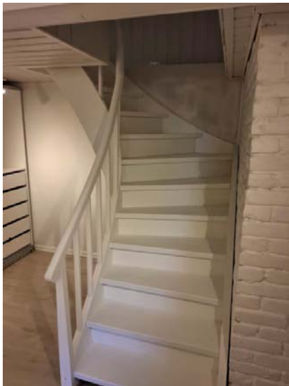
Trapp mellom kjelleretasjen og 1. etasje.
