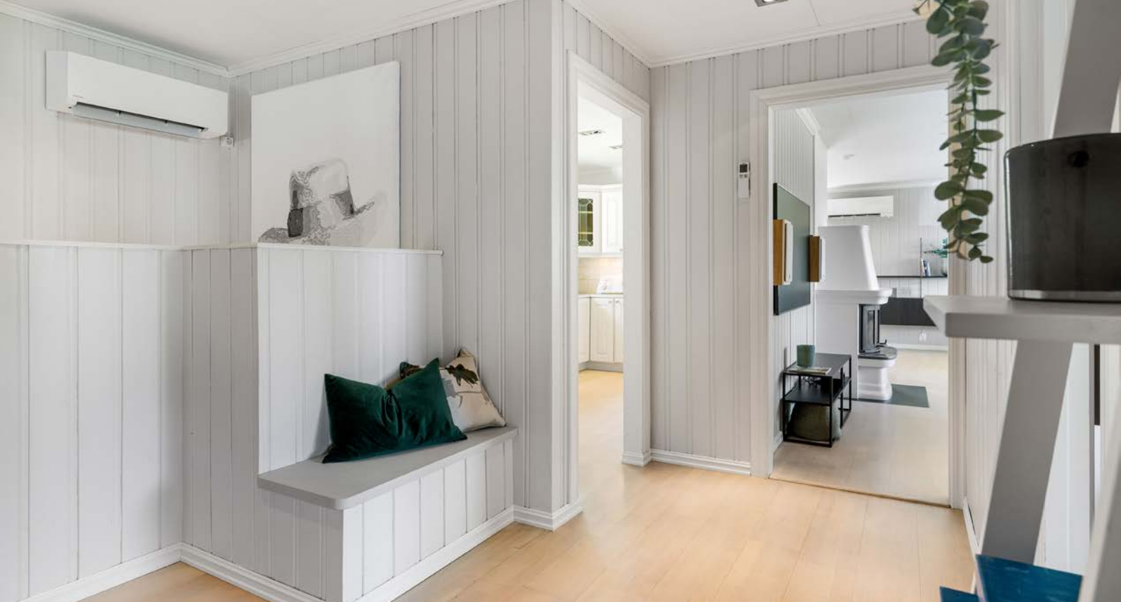
Trappegang med adkomst til alle etasjens rom. På veggen i trappenedgangen er det montert varmepumpe som sprer varmen godt i begge etasjene.
