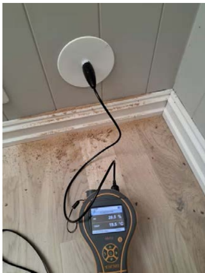
Bilde fra fuktmåling i utlektet veggkonstruksjon.
