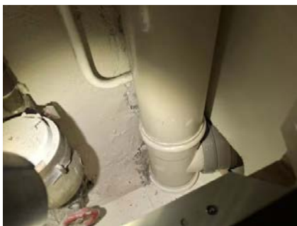
Deler av avløpsrørene er fra byggeår.
