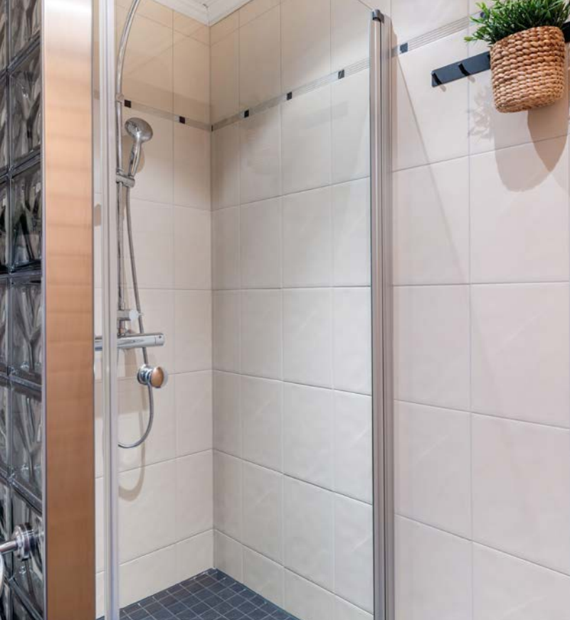
Dusjnise med glassfibervegg, dør og vegghengt dusjbatteri med regnfall.
