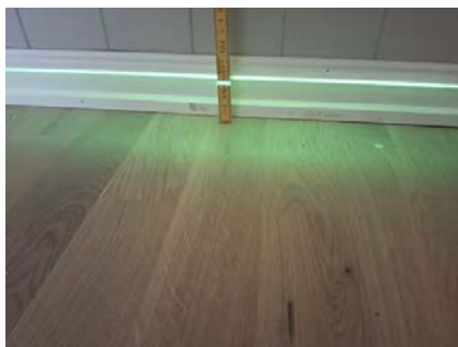
Etasjeskiller er kontrollert med nivelleringslaser.
