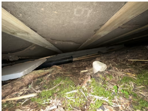
Viser stubbloft med asfaltimpregnerte plater under bod.
