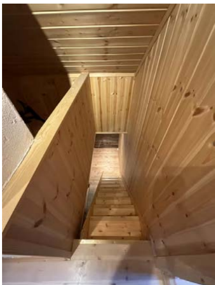
Viser trapp mellom 1 og 2.etasje.
