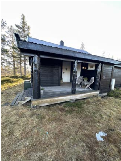
Viser overbygget inngangsparti med værbeskyttet krok.
