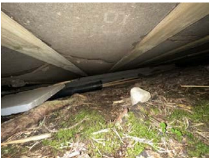
Viser stubbloft med asfaltimpregnerte plater under bod.
