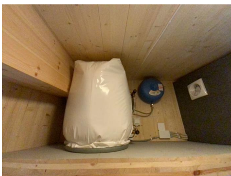
Besiktigelse av bereder.
