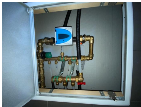
Besiktigelse av røropplegg.
