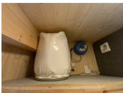
Besiktigelse av bereder.
