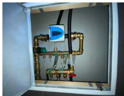
Besiktigelse av rørapplegg.
