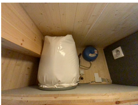
Besiktigelse av bereder.
