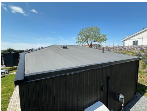
Besiktigelse av taktekke.
