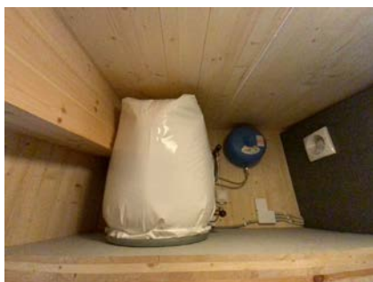
Besiktigelse av bereder.
