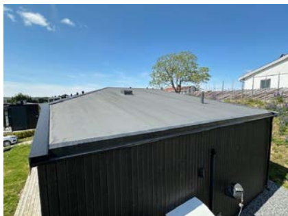
Besiktigelse av taktekke.
