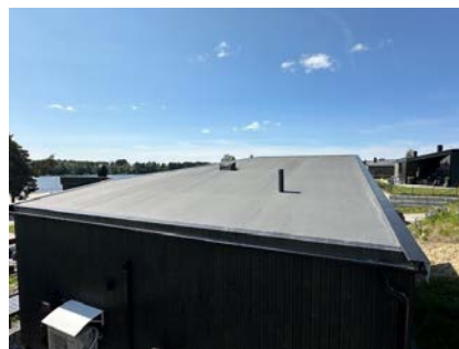
Besiktigelse av taktekke.
