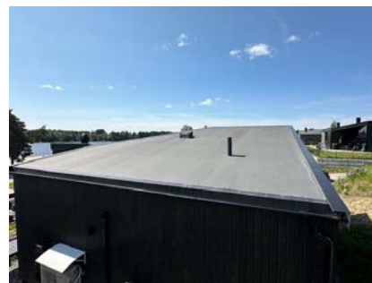
Besiktigelse av taktekke.
