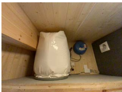
Besiktigelse av bereder.
