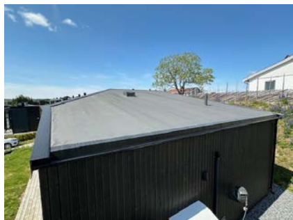
Besiktigelse av taktekke.
