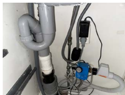
Røropplegg i kjøkkenbenk med Waterguard
