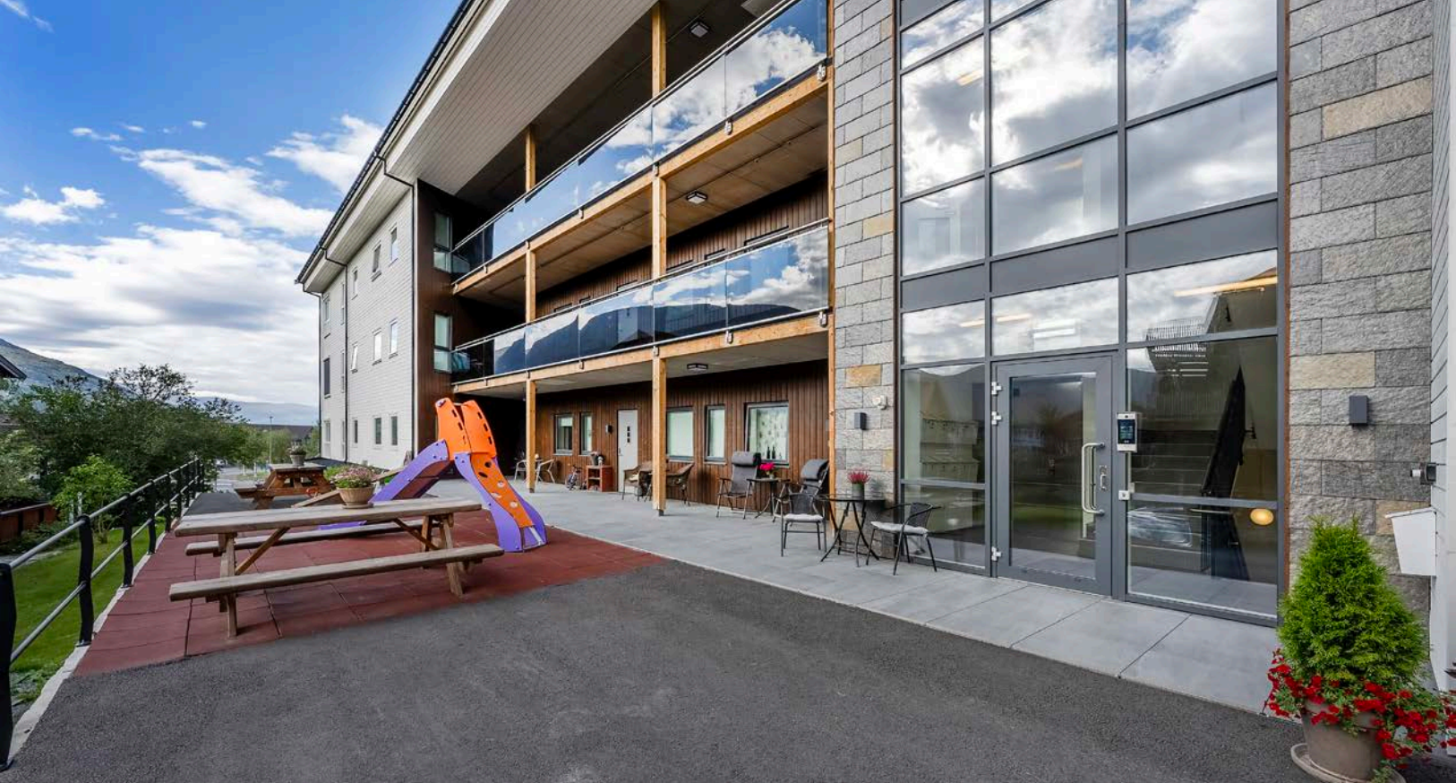
Inngangsparti med heis og trapperom Sameiets tomt er pent og ryddig opparbeidet
