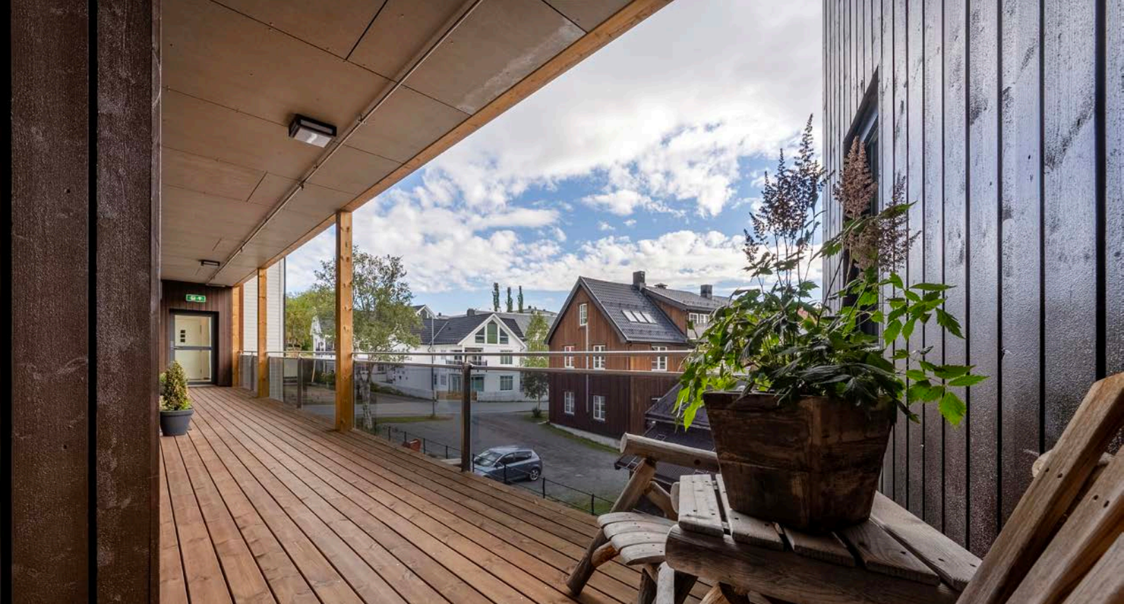
Takoverbygd svalgang mot leiligheten
