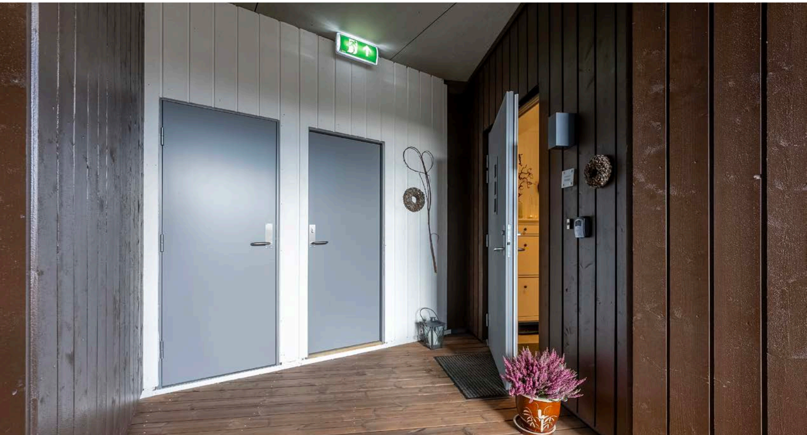
Takoverbygd inngangsparti med dør til rømningstrapp
