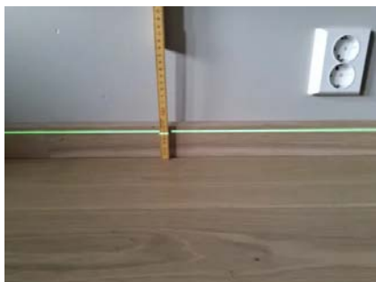
Etasjeskillet er kontrollert med nivelleringslaser.
