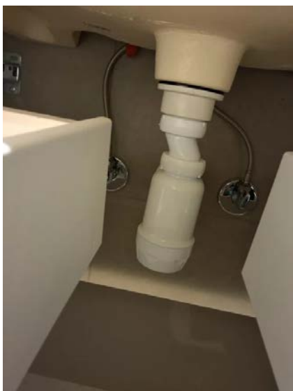
Leiligheten har synlige avløpsrør av plast.
