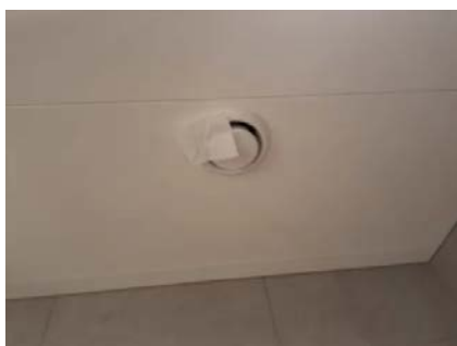
Avtrekkseffekt er testet med papir.
