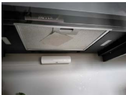
Avtrekkseffekt er testet med papir.
