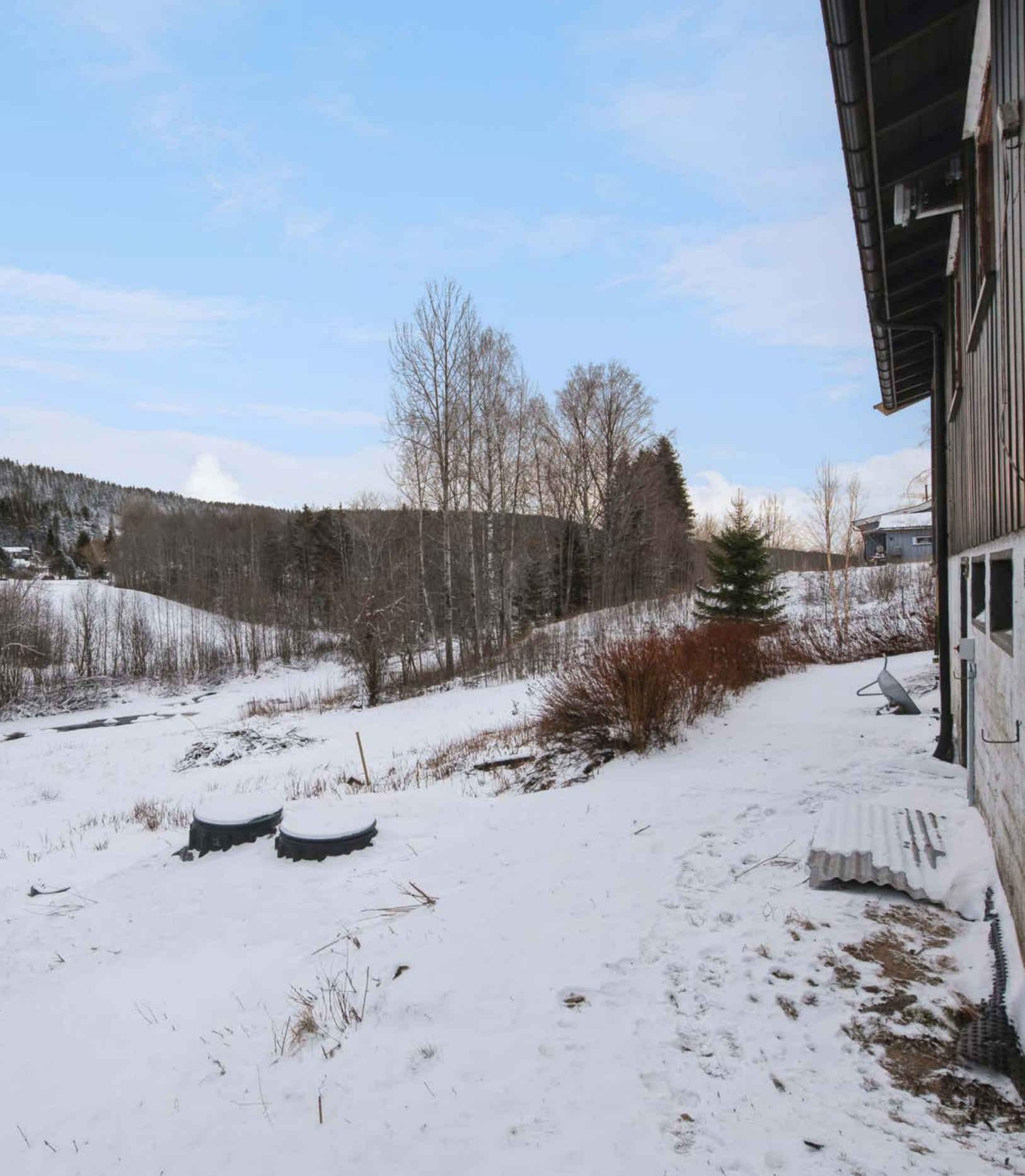
Det er nylig montert Biovac renseanlegg på eiendommen.
