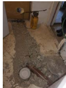
Betonggulv er pigget opp og nye avløpsrør er ført ut av bygning.
