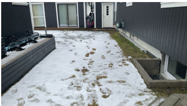
Lite fall ut fra bygning mot nord,
