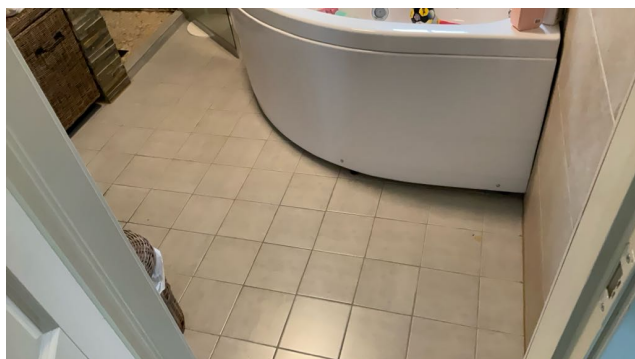
Fliser på gulv.
