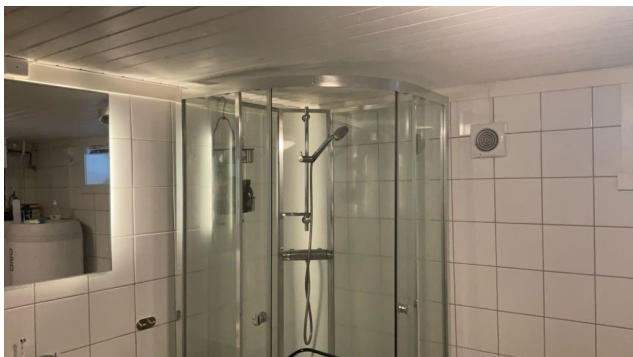
Vegger har fliser.
