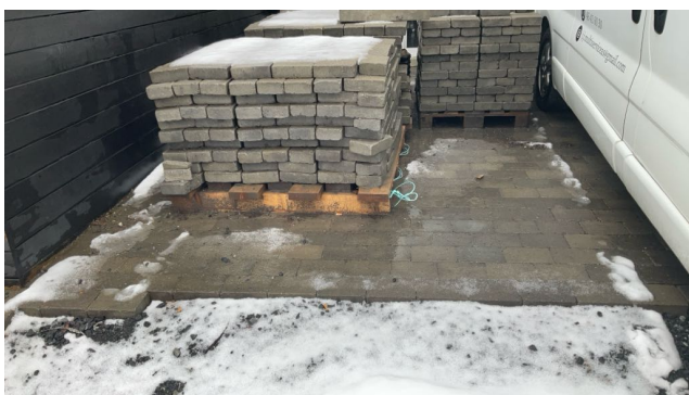
Belegningsstein er ikke ferdig lagt.
