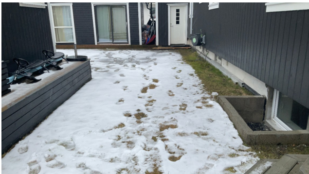
Grunnmursplast på vegg mot nord.
