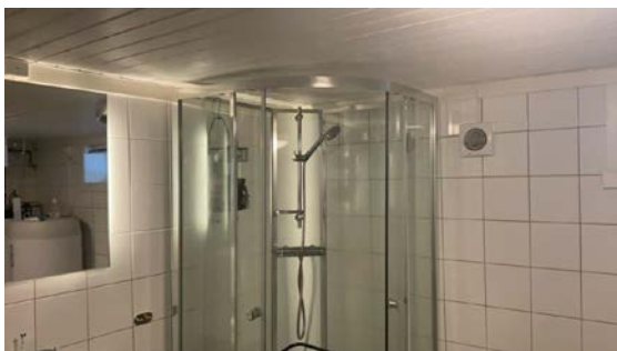
Vegger har fliser.
