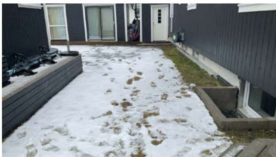
Lite fall ut fra bygning mot nord,
