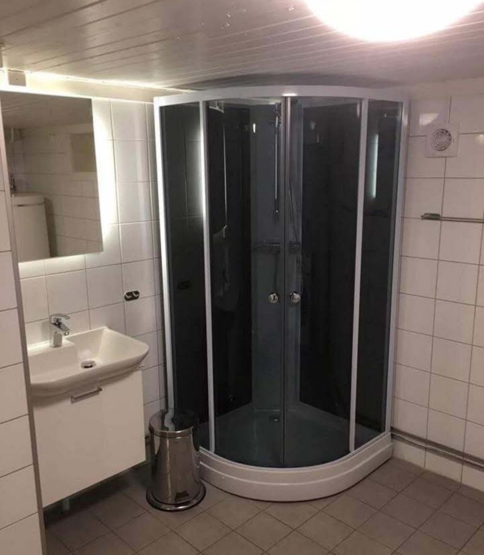
Selgers bilde - Bad til hybler i kjellerdel
