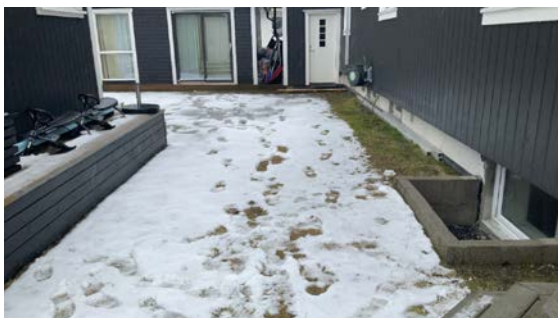
Grunnmursplast på vegg mot nord.
