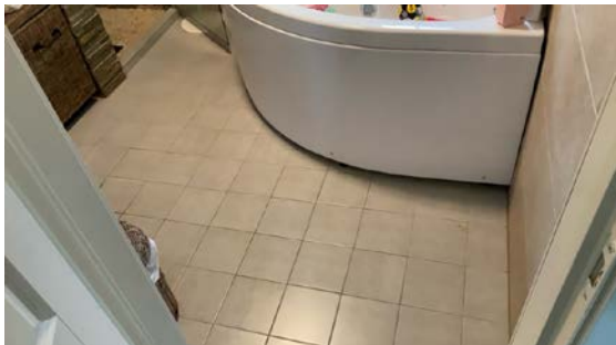
Fliser på gulv.
