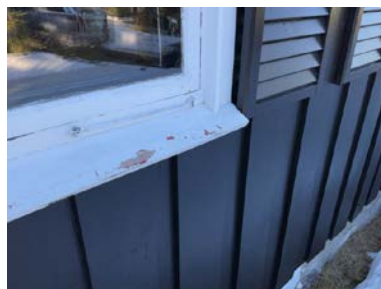
Omramming rundt vinduer er ført ned på beslag, risiko for fuktopptrekk i treverket.
