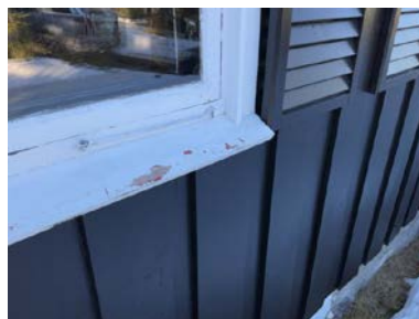
Omramming rundt vinduer er ført ned på beslag, risiko for fuktopptrekk i treverket.
