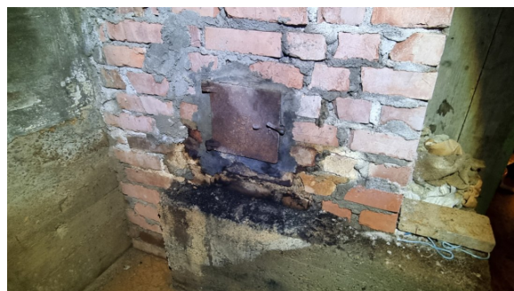
Kontroll av sotluke.
