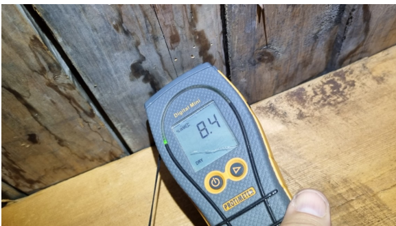
Fuktmåling på kaldloftet.
