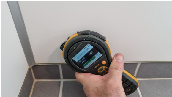
Fuktmåling i vegger.
