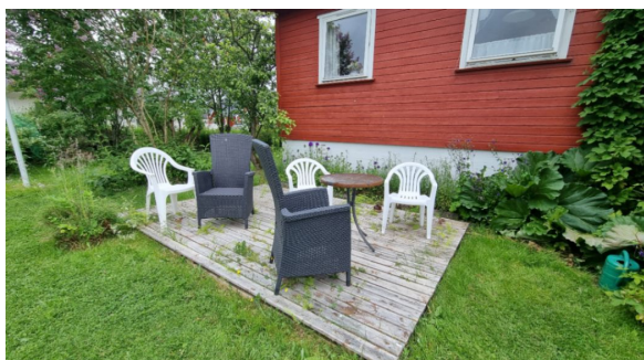
Markplattning av tre.
