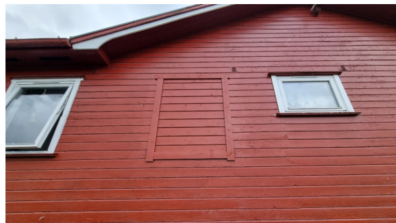
Ett vindu er tettet i forbindelse med utvidelse av baderommet.
