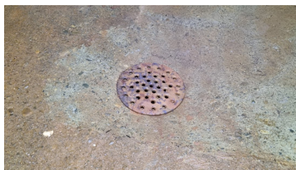
Soilsluk i kjeller.
