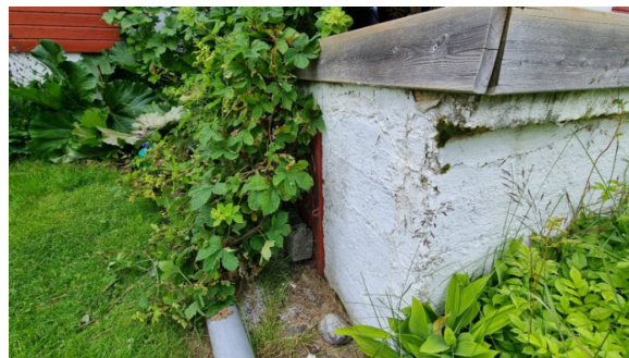
Trapp og repos er oppført over opprinnelige betongtrapp.
