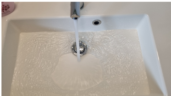
Kontroll av vanntrykk og avrenning.
