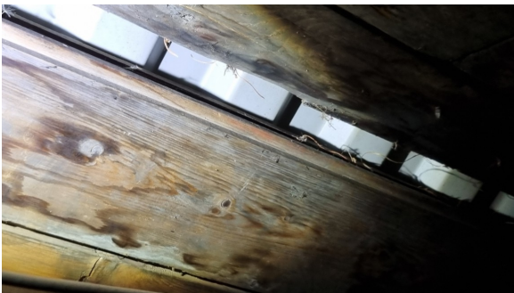
Åpninger opp under mønepanne.
