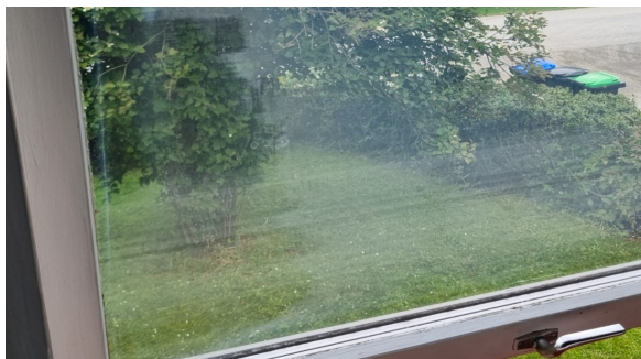
Punkttert vindu i det ene soverommet.
