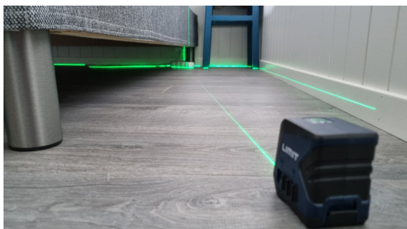
Kontroll av planavvik og skjevheter med krysslaser.
