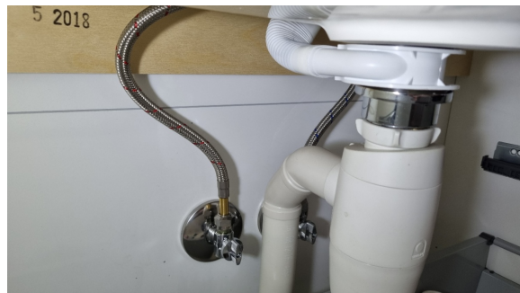
Kontroll av røropplegg under servanten.
