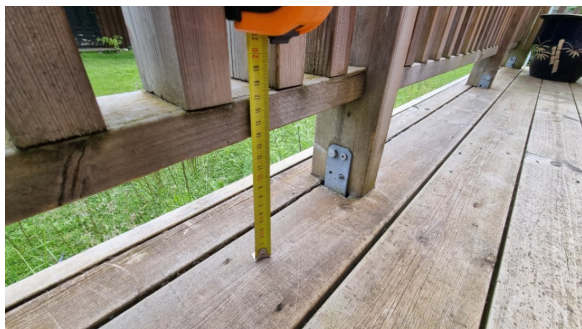
Måling av lysåpninger.
