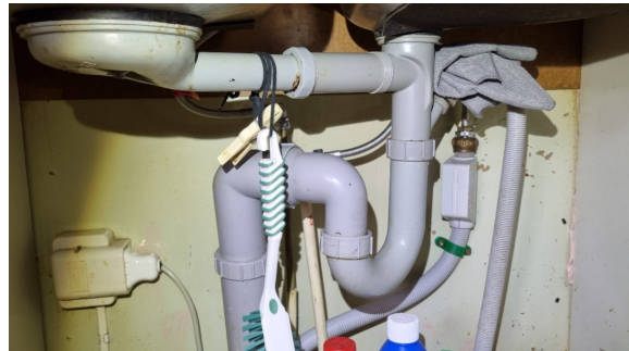
Kontroll av røropplegg under oppvaskkummen.
