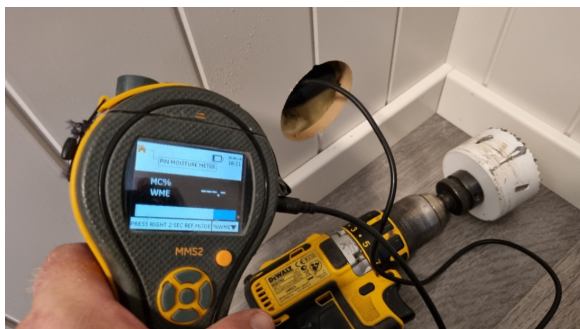
Hulltaking utført fra tilstøtende soverom.
