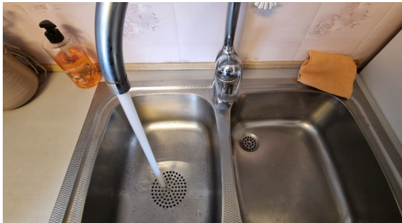
Kontroll av vanntrykk og avrenning.
