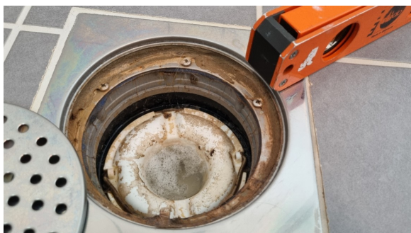
Kontroll av sluk.
