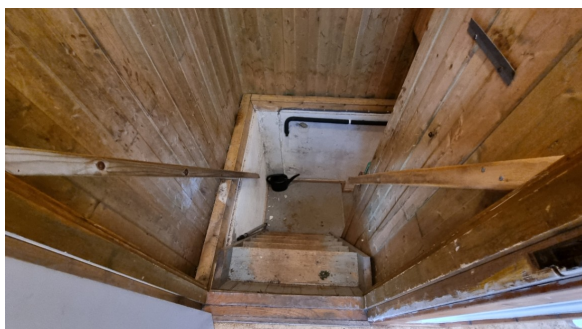
Trapp mellom etasjene.
