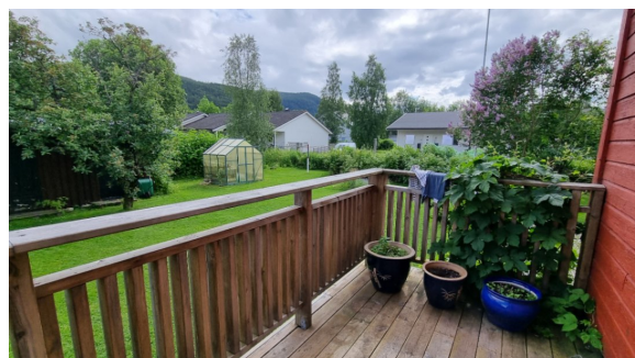
Altan ifm. inngangspartiet.
