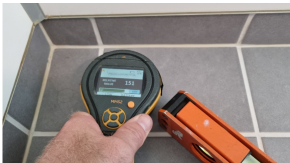
Fuktmåling og kontroll av fall mot sluk.
