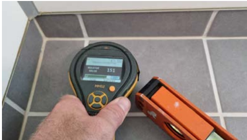
Fuktmåling og kontroll av fall mot sluk.
