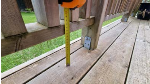
Måling av lysåpninger.
