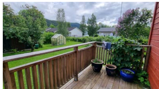
Altan ifm. inngangspartiet.
