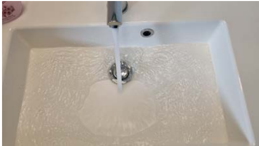
Kontroll av vanntrykk og avrenning.
