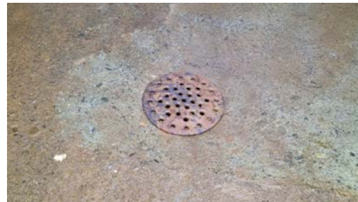
Soilsluk i kjeller.
