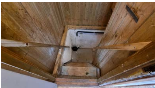
Trapp mellom etasjene.
