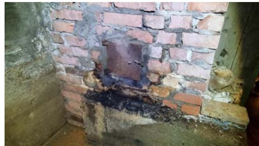
Kontroll av sotluke.
