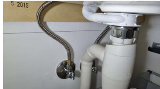
Kontroll av røropplegg under servanten.
