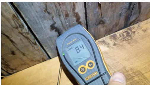
Fuktmåling på kaldloftet.
