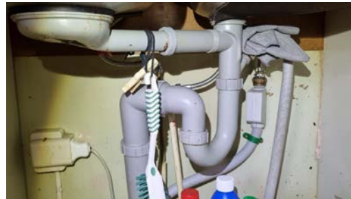
Kontroll av røropplegg under oppvaskkummen.
