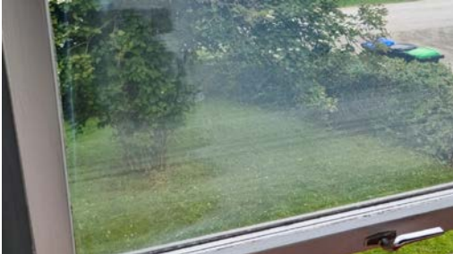
Punkttert vindu i det ene soverommet.
