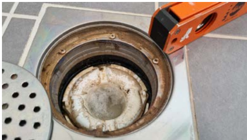
Kontroll av sluk.
