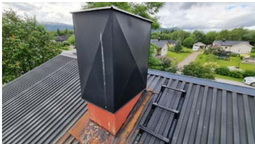
Øvre del av pipebeslaget er av nyere dato.
