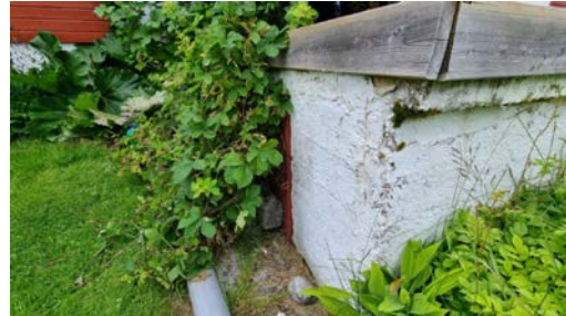
Trapp og repos er oppført over opprinnelige betongtrapp.
