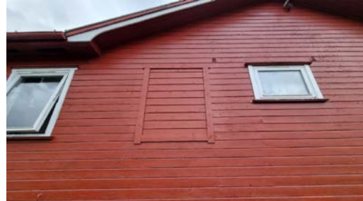
Ett vindu er tettet i forbindelse med utvidelse av baderommet.
