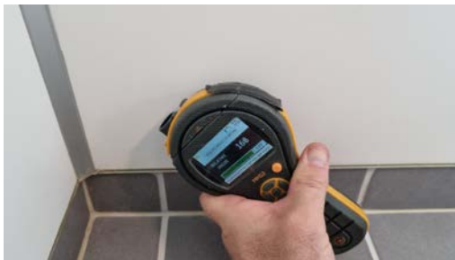
Fuktmåling i vegger.
