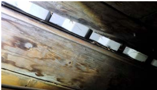
Åpninger opp under mønepanne.
