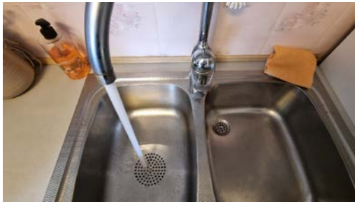
Kontroll av vanntrykk og avrenning.
