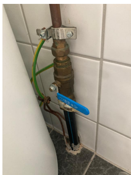
Stoppekran, funksjonstestet ok.
