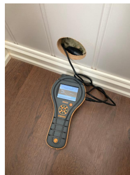
Måling av fukt i trevirke, med normale verdier.
