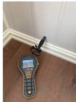
Måling av relativ fukt (RF) i vegg, med normale verdier.
