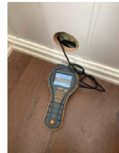
Måling av fukt i trevirke, med normale verdier.
