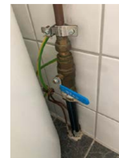
Stoppekran, funksjonstestet ok.
