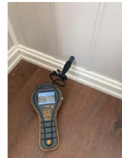
Måling av relativ fukt (RF) i vegg, med normale verdier.
