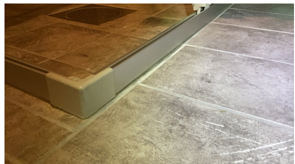
Tett skinne på gulv
