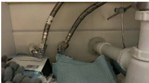
Utett gjennomføring under vask
