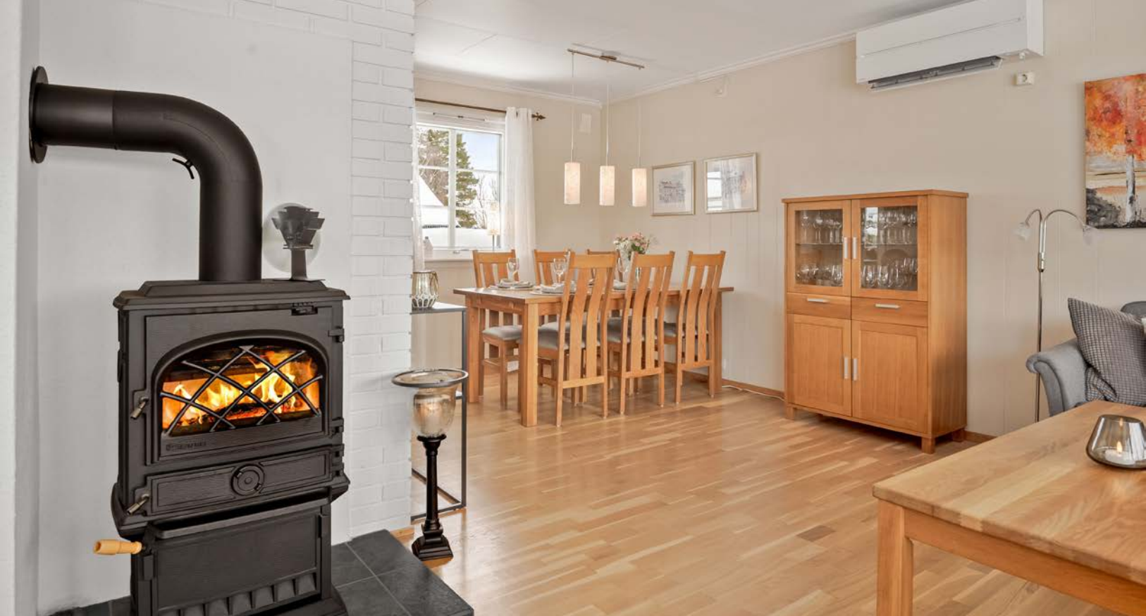
Peisovn fra 1999 sentralt plassert i mellomgangen stue og spisestue. Det er også varmepumpe i boilgen.
