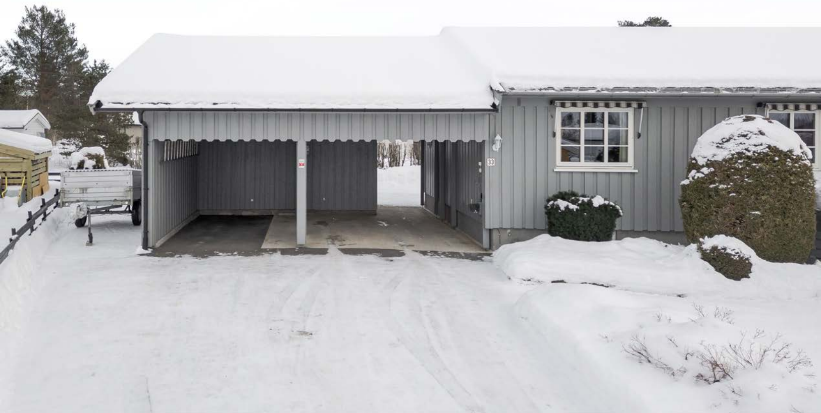
Dobbel carport med bod i bakkant.
