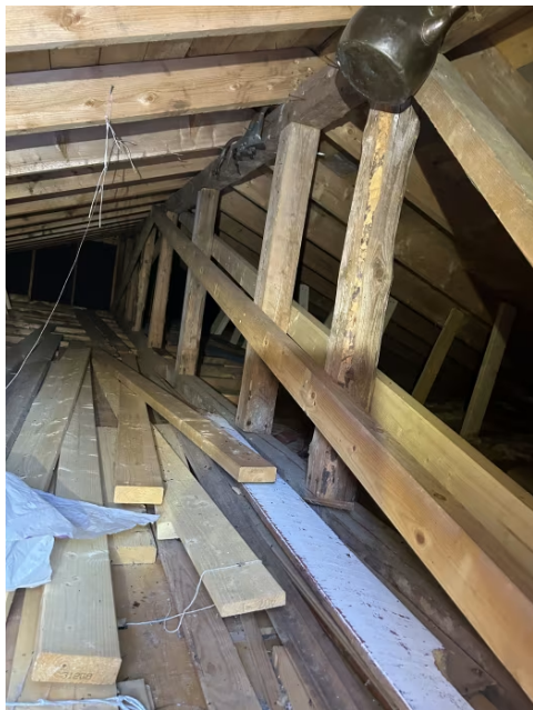
Utførte tiltak mot svai/nedbøy.
