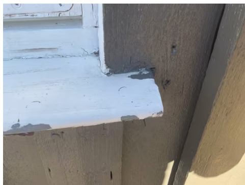
Panel går helt ned til vannbrett.
