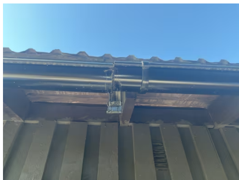
Skjøt i takrenne.
