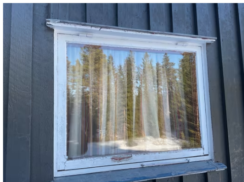
Ødelagte kittfalsler.
