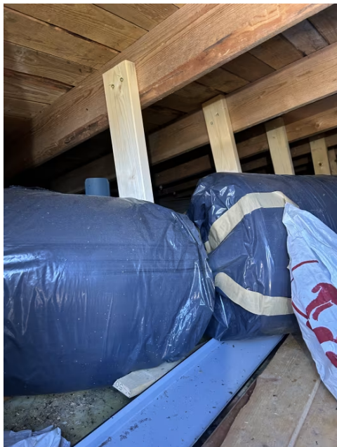
Utførte tiltak mot svai/nedbøy.
