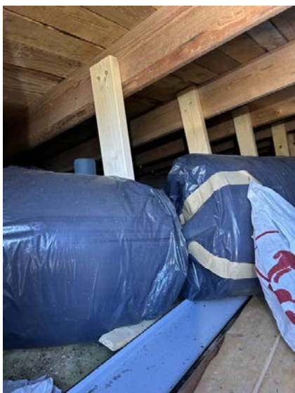
Utførte tiltak mot svai/nedbøy.
