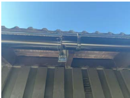
Skjøt i takrenne.
