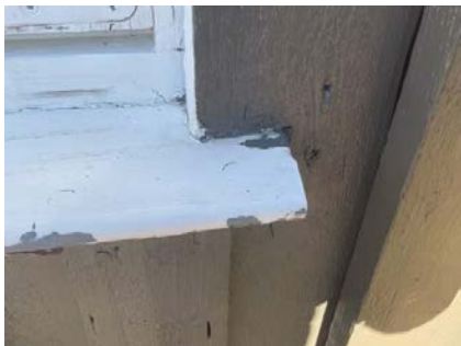
Panel går helt ned til vannbrett.
