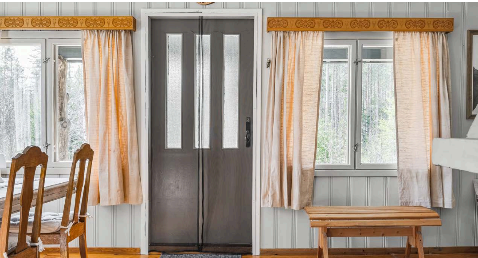
Inngangsdør i tre med glass og varevinduer i tre fra byggeår.
