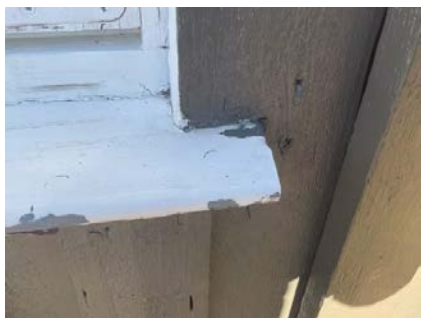
Panel går helt ned til vannbrett.
