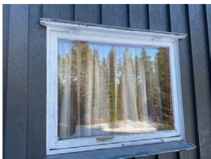
Ødelagte kittfalsler.
