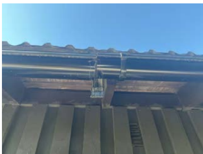
Skjøt i takrenne.
