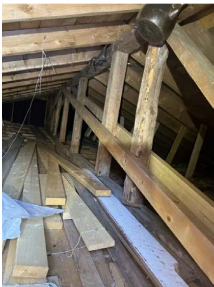
Utførte tiltak mot svai/nedbøy.
