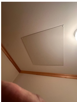
Ventilasjonsanlegg er montert i himling i bod.
