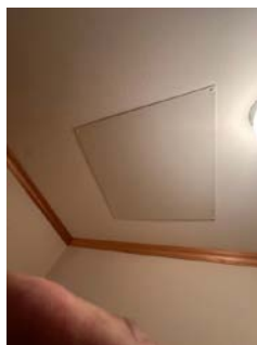
Ventilasjonsanlegg er montert i himling i bod.
