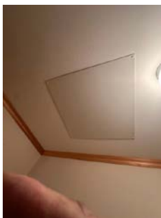
Ventilasjonsanlegg er montert i himling i bod.
