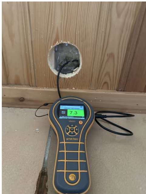
Hulltaking og fuktsøk foretatt i utlektet yttervegg.
