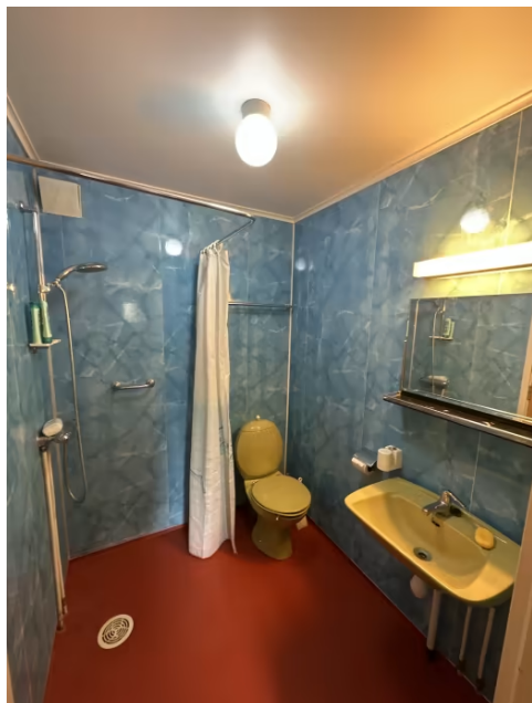
Viser baderom i kjeller.
