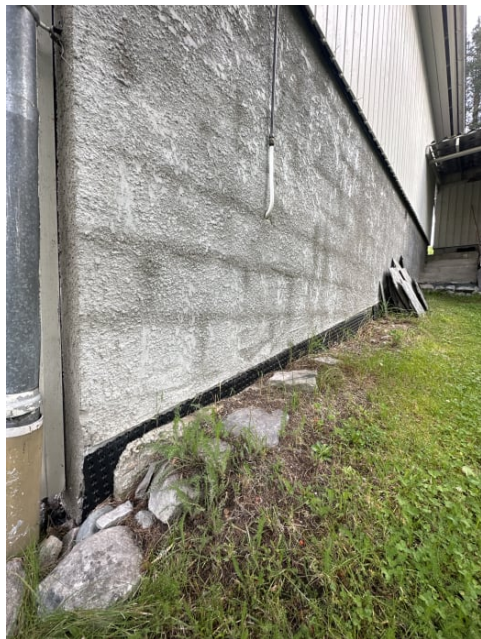
Viser bruk av knotteplast.
