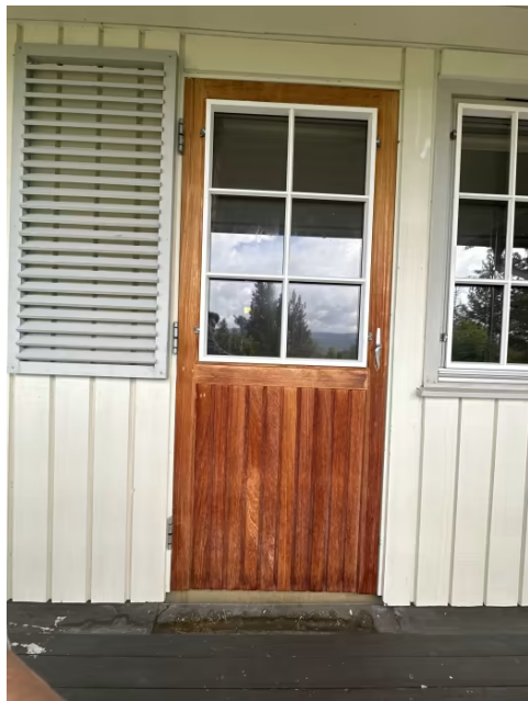
Viser balkongdør med glassfelt.
