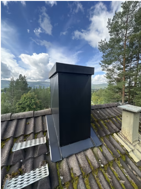
Viser beslagløsning rundt pipe.
