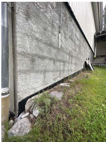
Viser bruk av knotteplast.
