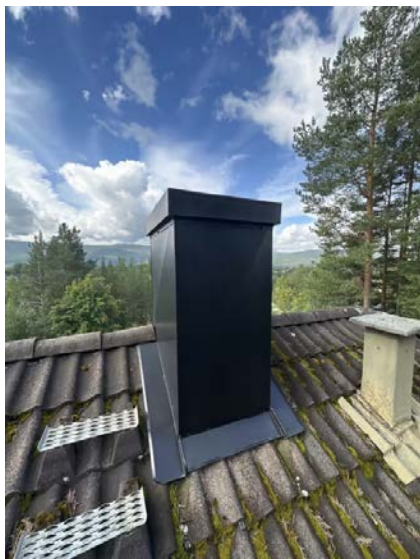
Viser beslagløsning rundt pipe.
