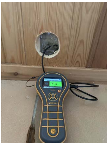
Hulltaking og fuktsøk foretatt i utlektet yttervegg.
