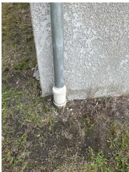
Taknedløp antatt ført til drenering under bakken.
