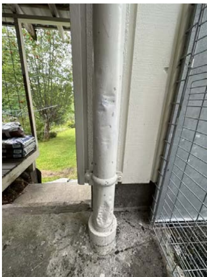
Vise bulker på nedløpsrør.
