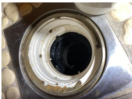
Sluk uten synlig membran.
