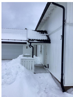
Takflaten som er vurdert til å ikke utgjøre fare for ras.
