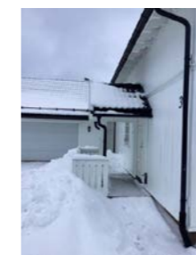
Takflaten som er vurdert til å ikke utgjøre fare for ras.
