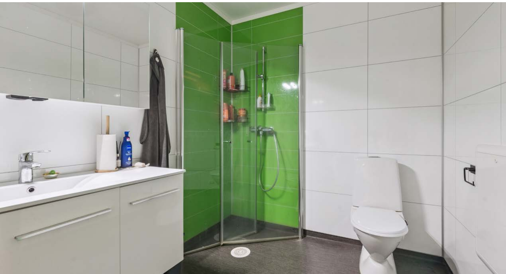
Bad i hybelleilighet har vinylbelegg m/varme på gulv og våtromsplater på vegger.
