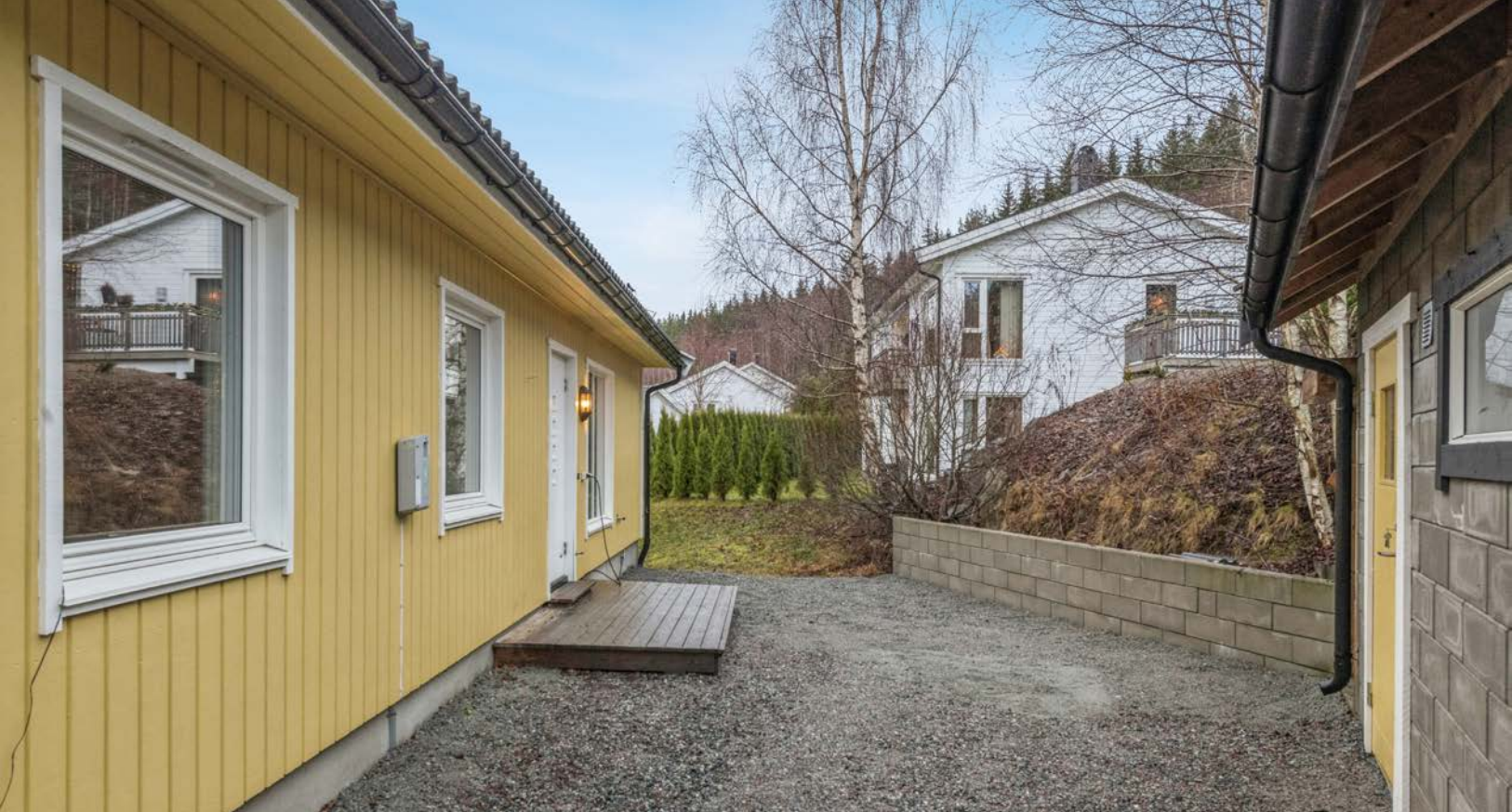
Inngangsparti til boligen hovedetasje.
