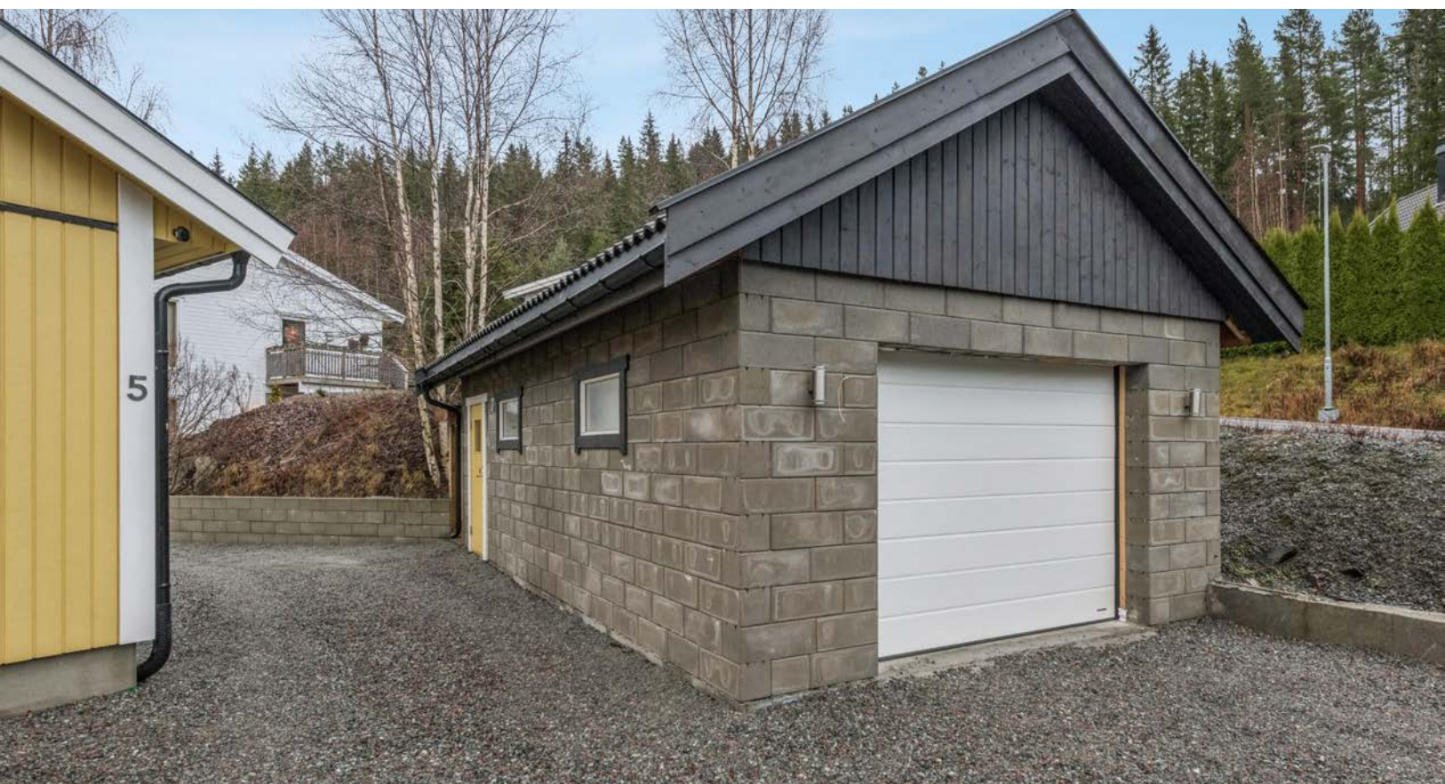
Garasje med betongplatefundament og vegger av forskalingsblokker, bygget i 2021.
