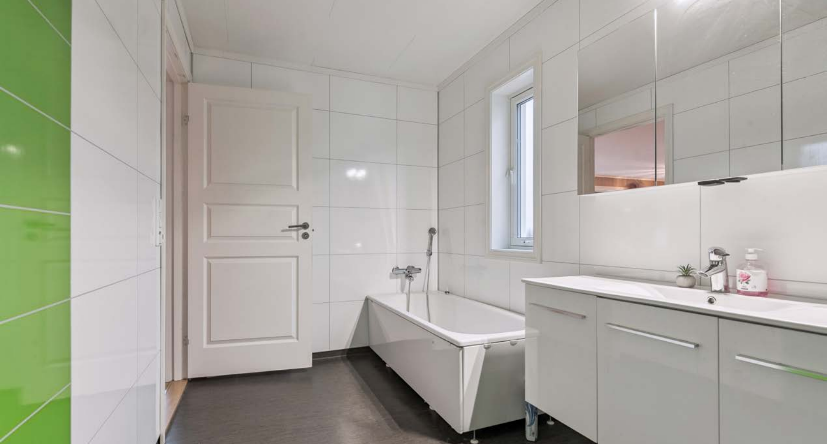
Bad i 1. etasje med vinylbelegg med varme i gulvet og våtromsplater på veggene.
