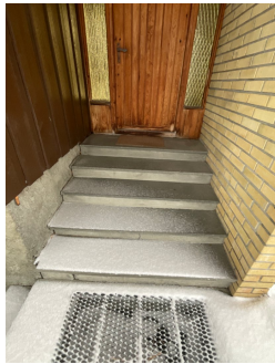
Trapp baksiden av hovedinngang
