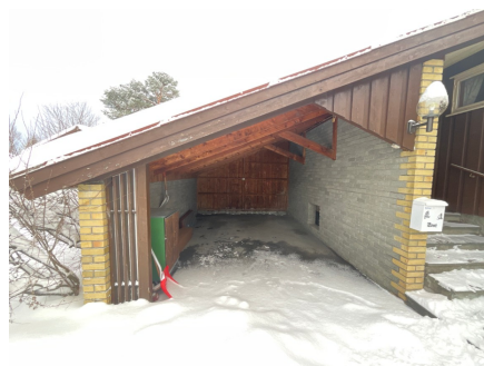
Murvegger i carport
