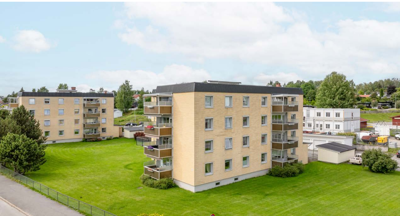
En perfekt leilighet for enslige, par, eldre og førstegangskjøpere!
