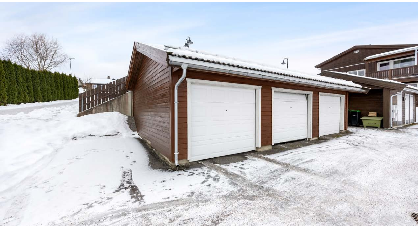
Til leiligheten medfølger parkering i garasje i felles rekke. Garasjen har motorisert leddport.
