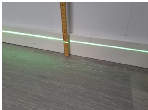
Etasjeskille er kontrollert med nivelleringslaser.
