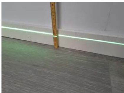
Etasjeskille er kontrollert med nivelleringslaser.
